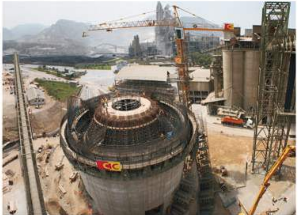
Multisó de 70 metros de altura para Cementos Lima - Abril 2009
